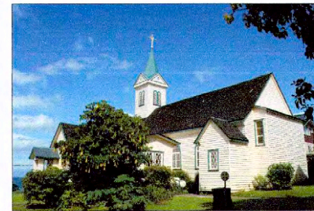
Vista parcial de las fachadas norponiente y surponiente.
