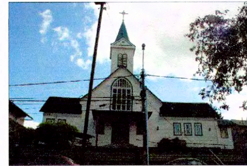
Vista de la fachada principal (nororiente).
